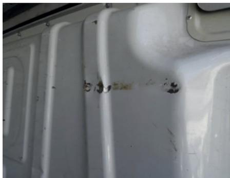
Abrasioni o graffi con principio di corrosione.
